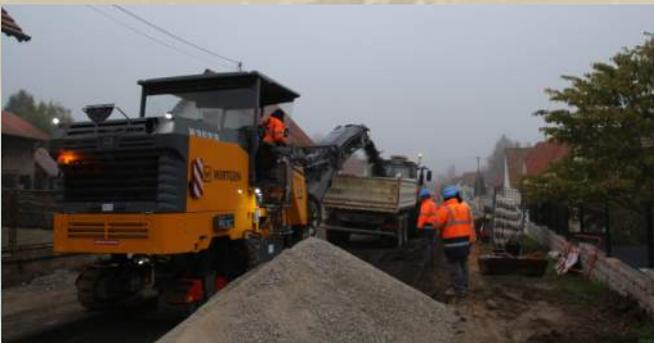
Les travaux de la deuxième tranche de l'aménagement de la rue d'Uhrwiller ont débuté mi-octobre par le contrôle du réseau d'assainissement puis le décapage des enrobés (voir photo). Ont suivi, la mise en place des bordures pour délimiter les trottoirs, la création de places de stationnement et pour finir, la pose du tapis de roulement prévue mi-décembre.
